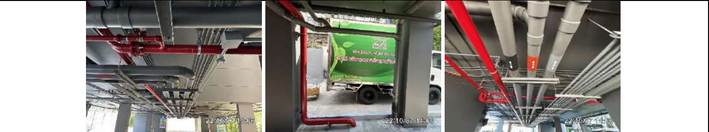
รูปที่ ผ7.40 ระบบท่อขึ้น (Stand Pipe)
