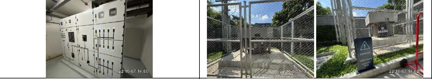
รูปที่ ๗7.27 สวิตช์บอร์ดแรงสูงชนิดติดตั้งภายในอาคาร และสวิตช์บอร์ดแรงต่ำ
