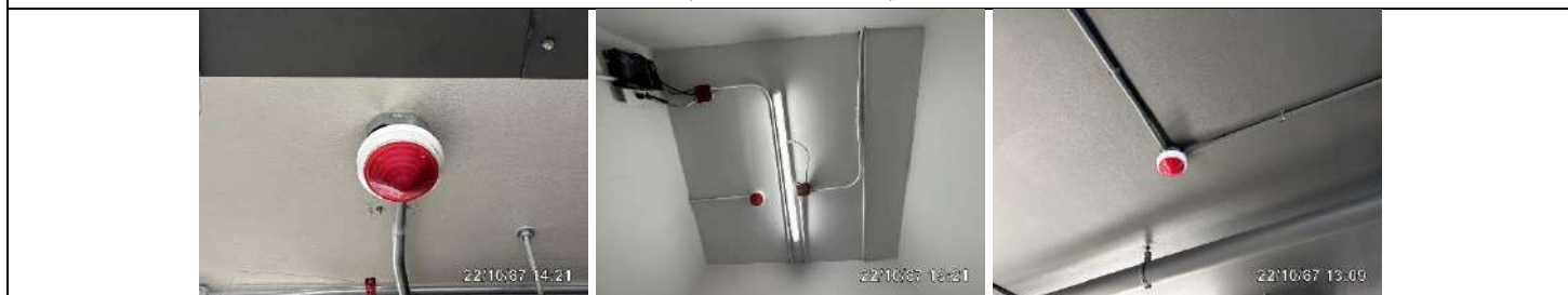
รูปที่ ผ7.47 เครื่องตรวจจับความร้อน (Heat Detector)
