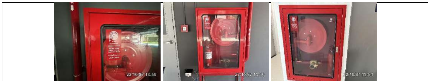
รูปที่ ผ7.41 ตู้เก็บสายฉีดน้ำดับเพลิงพร้อมอุปกรณ์ (FHC)
